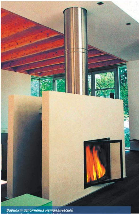
Вариант исполнения металлической дымоходной системы Schiedel
