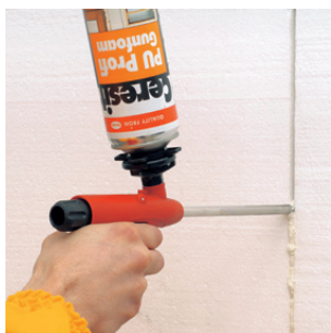
Рис. 21 Заполнение зазоров монтажной пеной
