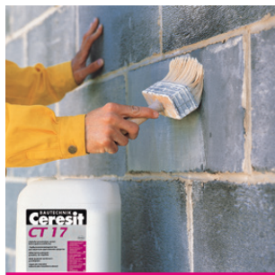
Рис. 7 Грунтование основания
