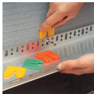
Рис. 9в Подкладка пластиковой шайбы
