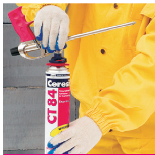
Рис. 13 Присоединение баллона к пистолету
