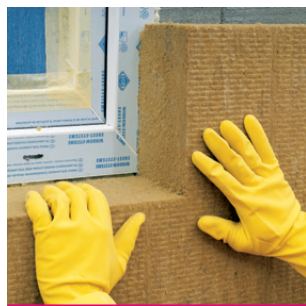
Рис. 25 Установка утеплителя на откосах
