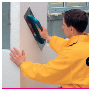
Рис. 18 Установка плит в проектное положение
