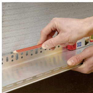
Рис. 9б Разметка линии установки
