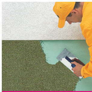
Рис. 52 Нанесение мозаичной штукатурки
