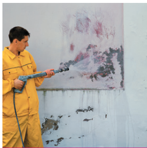
Рис. 3 Очистка основания моечной машиной
