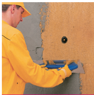
Рис. 40 Грунтование минераловатных плит
