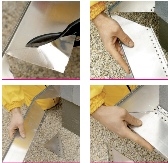
Рис. 10 Монтаж цокольной планки на углах здания
