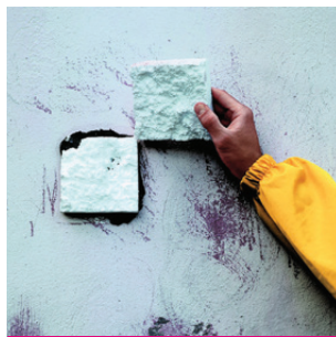
Рис. 6 Проверка прочности основания «на отрыв»
