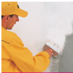
Рис. 44 Грунтование базового армирующего слоя
