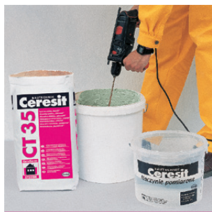
Рис. 45 Приготовление декоративных штукатурок
