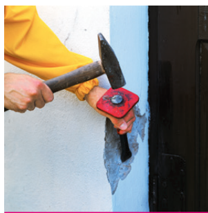
Рис. 2 Удаление непрочных участков основания с помощью зубила
