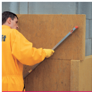
Рис. 14 Контроль установки плит утеплителя
