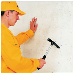
Рис. 5 Удаление непрочных участков основания молотком
