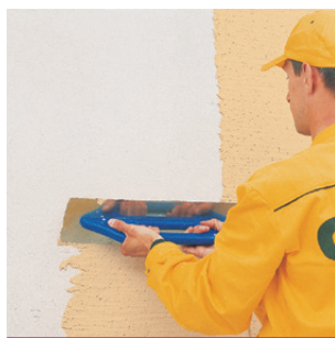
Рис. 47 Нанесение декоративной штукатурки на основание
