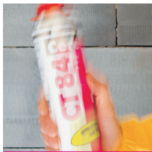
Рис. 12 Встряхивание баллона
