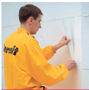
Рис. 20 Заделка открытых швов
