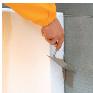
Рис. 22 Удаление излишков клеевого состава
