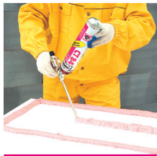
Рис. 17 Нанесение полиуретанового клея на теплоизоляционную плиту
