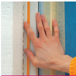
Рис. 26 Установка примыкающего профиля
