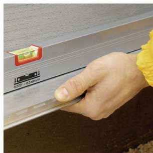
Рис. 9а Установка горизонтального положения при помощи уровня
