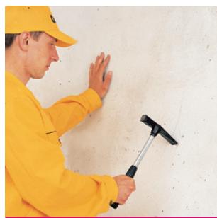
Рис. 1 Удаление непрочных участков основания молотком
