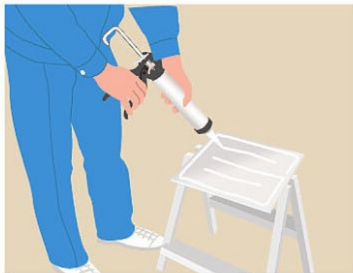
Нанесение строительного клея полосками
