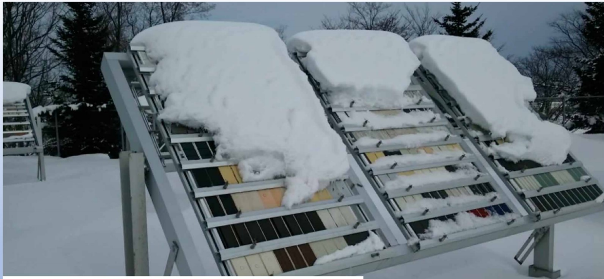
Испытание под открытым небом в холодной местности Размещение панелей TORAY LEAD под открытым небом в холодной местности (Хоккайдо, г.Асахикава)
