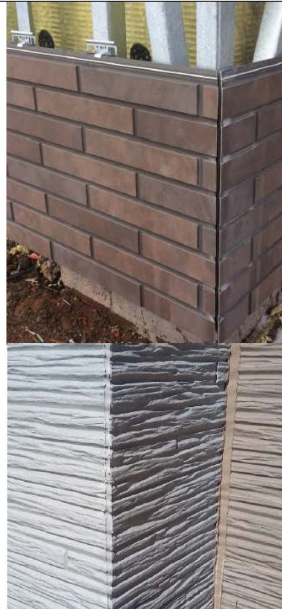
Стык панелей с подпиллом на 45°
