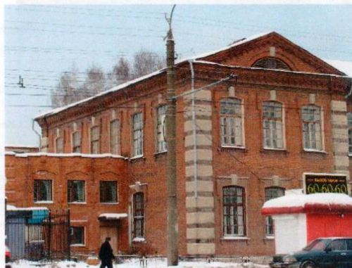
Фото 4 пристрой к зданию, вид с ЮЗ
