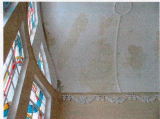
Фото 11, 12 панно, гирлянды из гипса, на стенах лестничной клетки второго этажа и следы протечек
