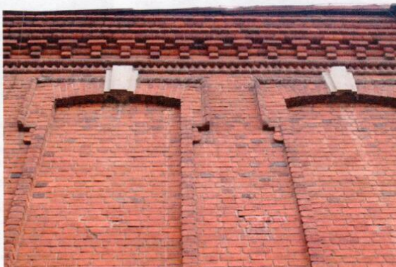
Фото 6 венчающий карниз, вид с В
