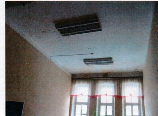
Фото 20, 21 следы протечек кровли на потолке в кабинетах второго этажа
