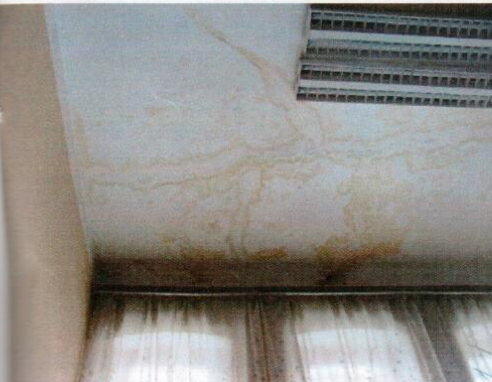
Фото 20, 21 следы протечек кровли на потолке в кабинетах второго этажа
