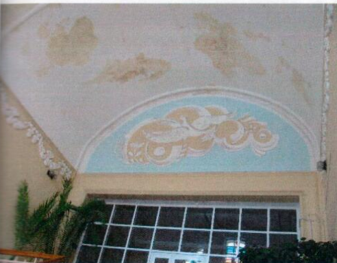
Фото 11, 12 панно, гирлянды из гипса, на стенах лестничной клетки второго этажа и следы протечек
