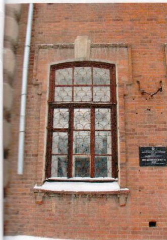
Фото 5 форма оконного проема, декоративное обрамление, рустовка, водосточные трубы недостаточной длины,
