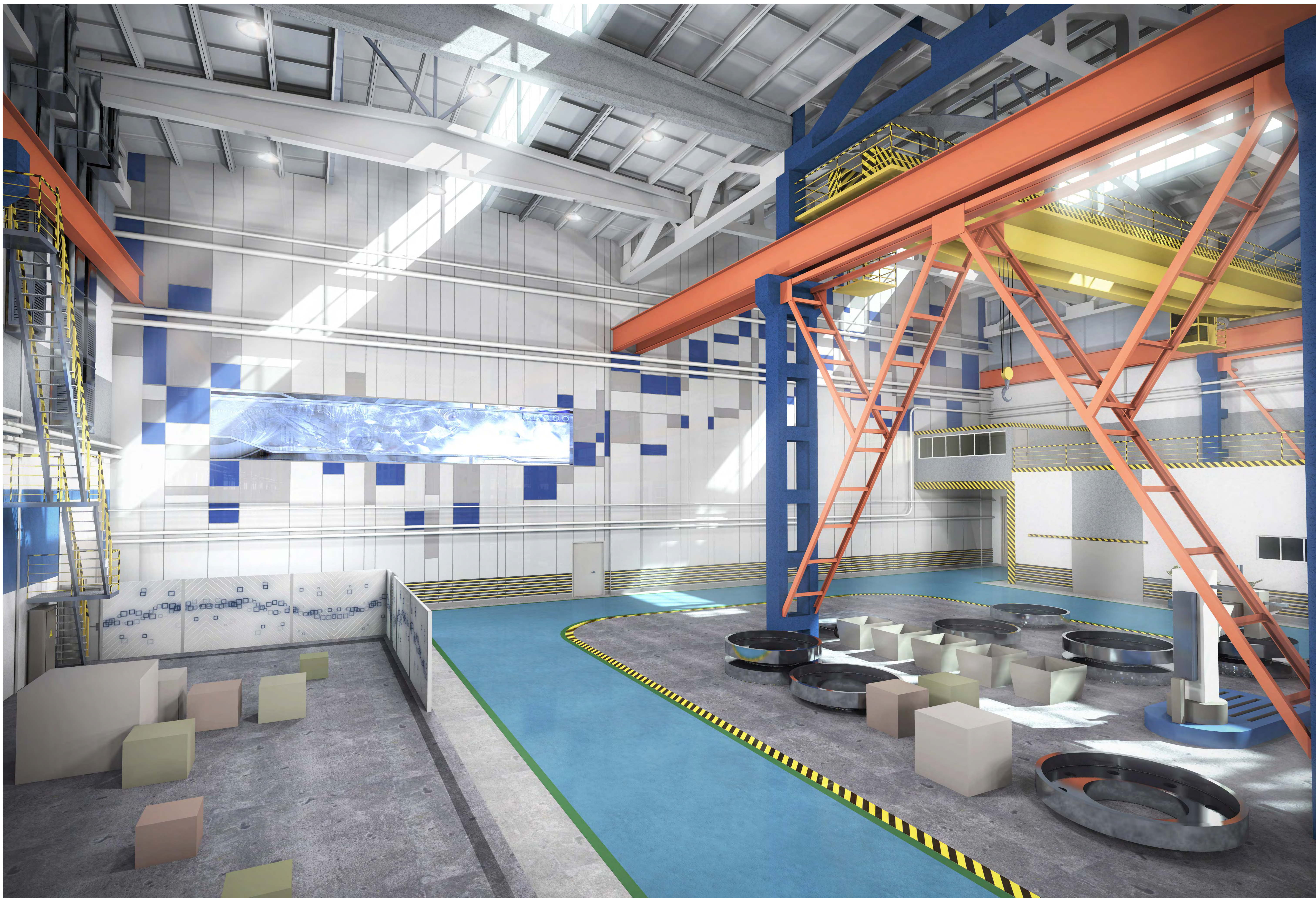
Торцевые стены цеха облицованы металлокассетами на несущей системе из металлических элементов, образующими определенный геометрический рисунок
