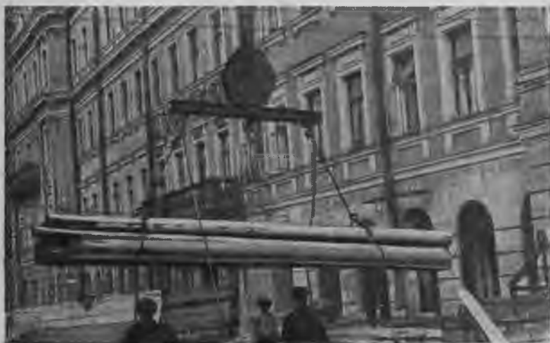
Рис. 27. Подача леса кабель-краном.
