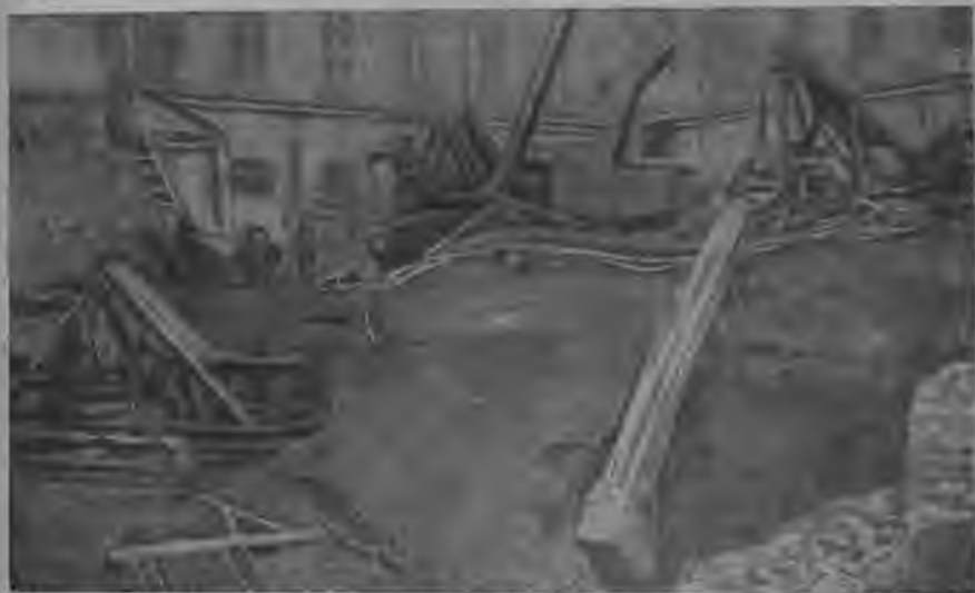
Рис. 13. Выемка грунта экскаватором „Комсомолец“ с обратной лопатой.
