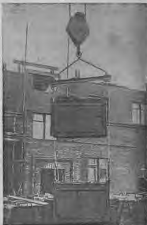
Рис. 20. Подъем контейнеров башенным краном.
