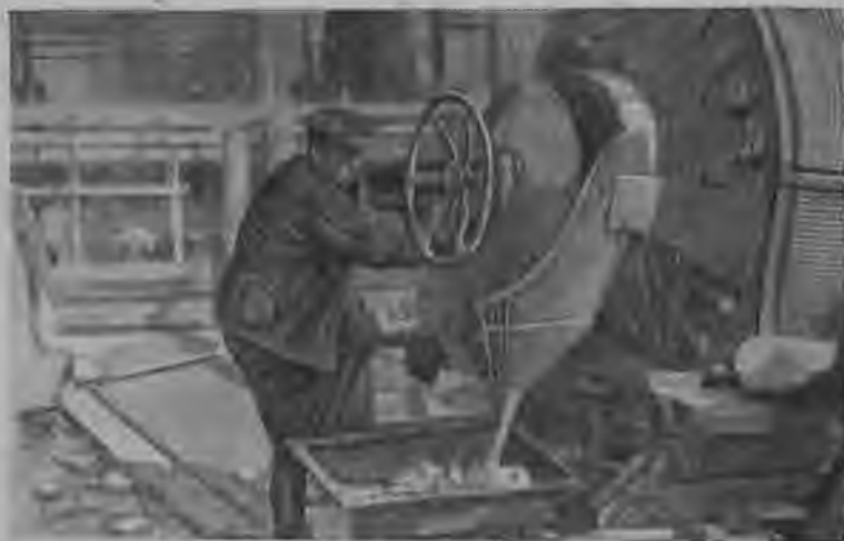
Рис. 9. Разгрузка бетона из автобетоньерки.
