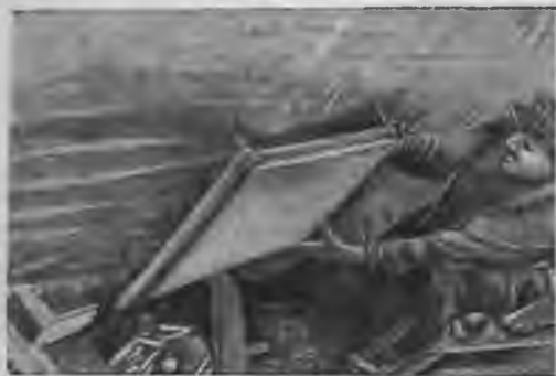
Рис. 62. Крепление белых плит к стене.
