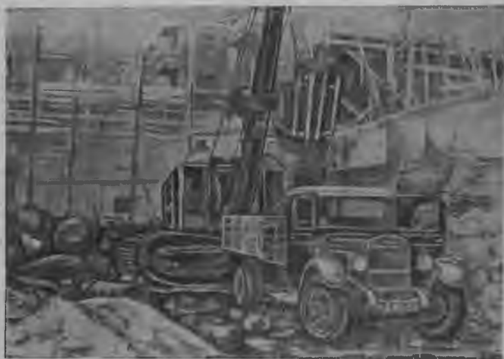
Рис. 14. Погрузка грунта в автомашины экскаватором ЛК.
