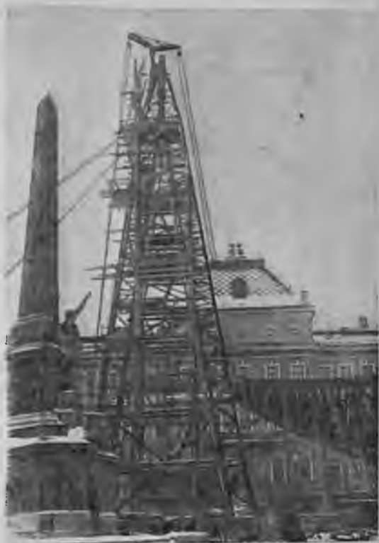
Рис. 24. Сборка кабель-крана способом наращивания.
