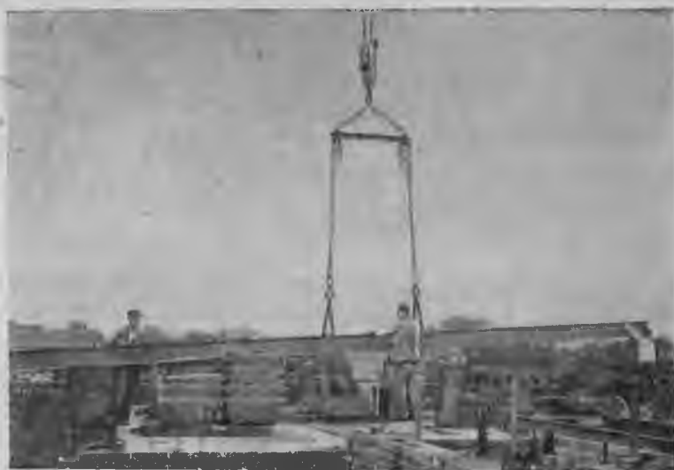
Рис. 34. Укладка прогонов башенным краном.
