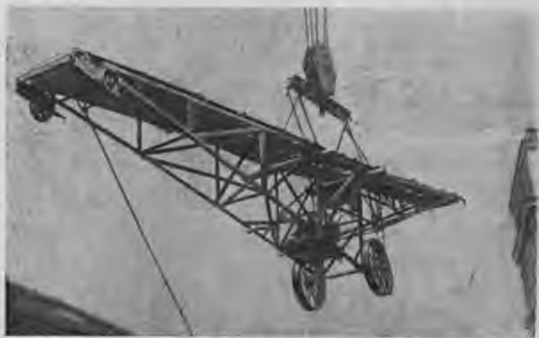
Рис. 28. Подъем транспортера кабель-краном.
