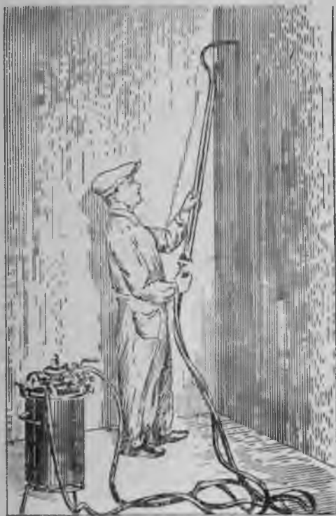
Рис. 58. Удочка-сопло для малярных работ.
