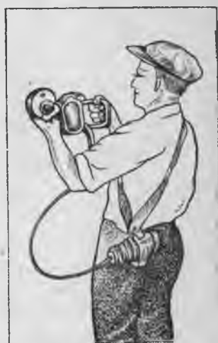
Рис. 50. Затирка мотоинструментом МИ.
