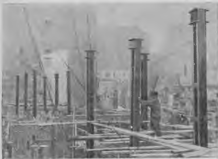
Рис. 40. Монтаж металлических колонн.
