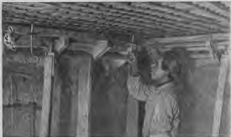
Рис. 54. Крепление карнизных форм.
