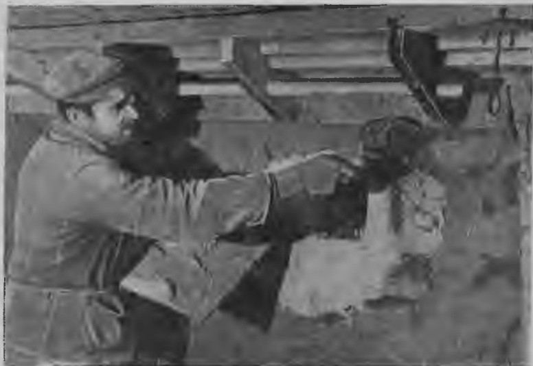
Рис. 53. Отмазка при установке карнизных форм.
