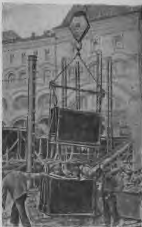
Рис. 22. Установка контейнера на леса.
