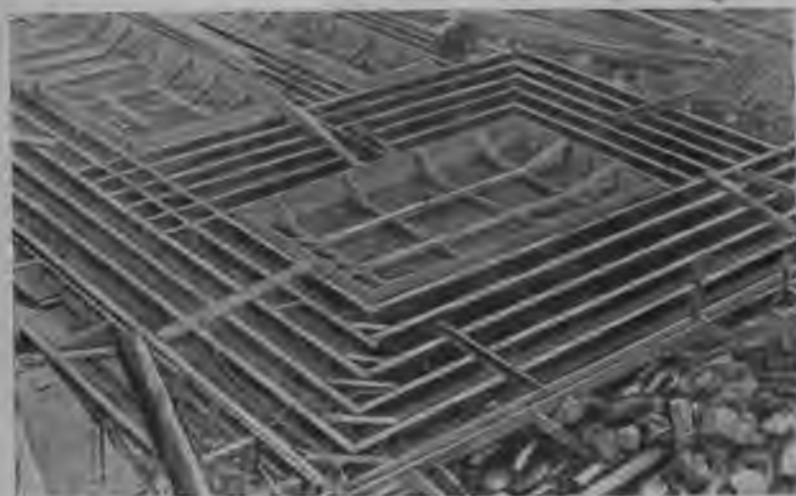
Рис. 7. Железный ростверк.
