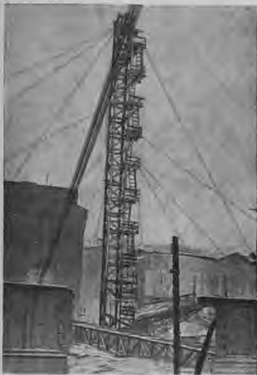
Рис. 23. Шахтный подъемник для подачи раствора.
