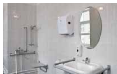
Душевая оборудована поручнями и складным сиденьем.
