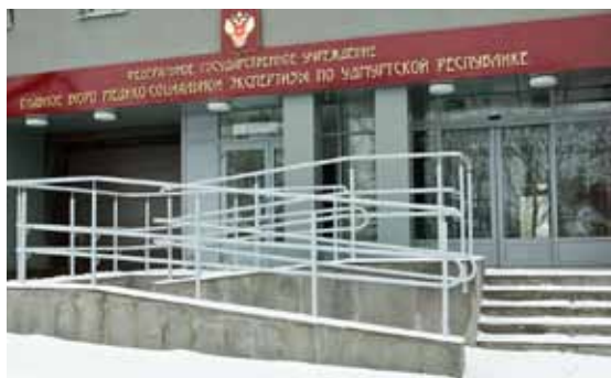
Специальными поручнями оснащены пандусы перед главным входом в здание бюро.
